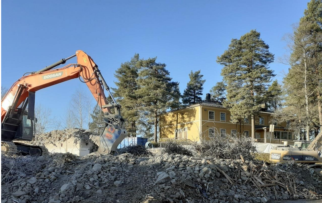
Kuva Heini Liimatainen, kaupungintalon purkutyömaa Seuratalon edustalla
